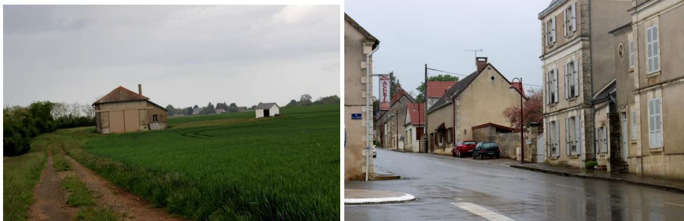
Photo 24 : Bâti proches de la ZIP (à gauche, au niveau de « Champ Fleury » ; à droite, bourg de Garchy)
